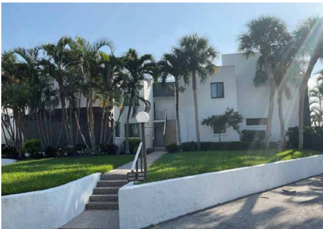
Condo Building D1
