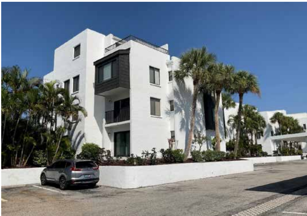
Condo Building A3
