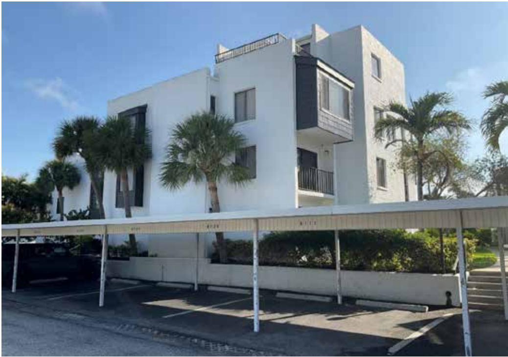
Condo Building A5
