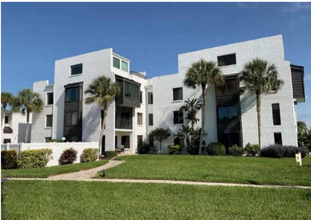
Condo Building A4
